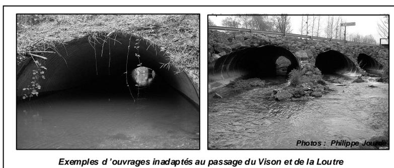
Exemples d'ouvrages inadaptés au passage du Vison et de la Loutre
