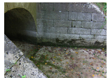
Ouvrage 5 : voûte transparent à l'étiage, non transparent en hautes eaux
