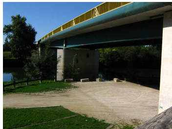
ouvrage 1 = Viaduc (transparent en toutes saisons)
