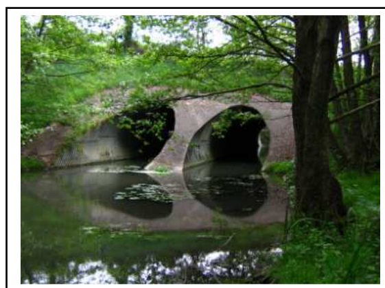
Franchissement du Bramerit par l'A10
