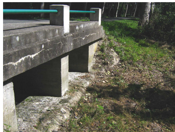
ouvrage 3 > transparent à l'étiage & niveau courant
